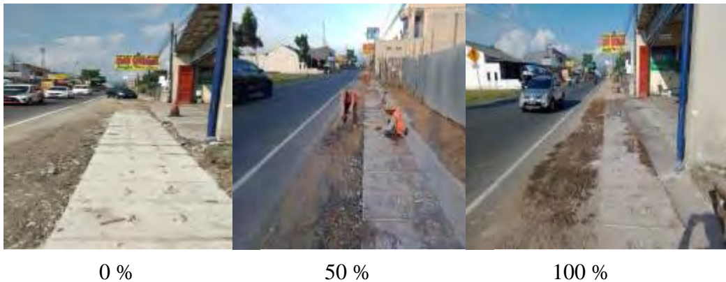
Gambar 3-5 Penanganan Drainase, Trotoar dan Fasilitas Keselamatan Jalan: Saluran Berbentuk U Tipe DS 4 Jalan Yogyakarta - Piyungan (4+650)
