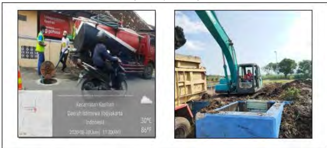
Gambar 2-15 Penggelontoran Jaringan Air Limbah dan Pembersihan Dan Pembuangan Lumpur Kering SDB
