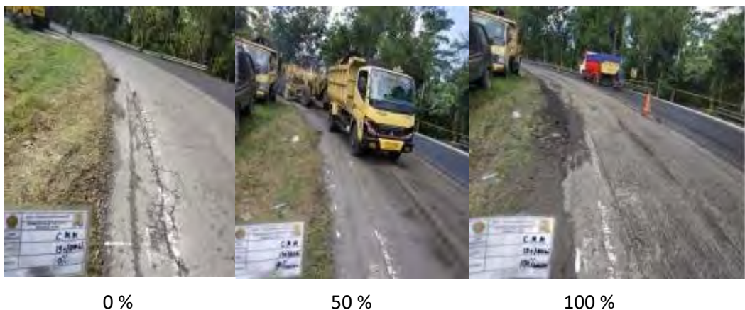
Gambar 3-6 Rehabilitasi Minor Jalan Bantul-Gading: Galian Perkerasan Beraspal dengan CMM dan Laston LapisAus Plastik (AC WCP)19+050 (Ki)
