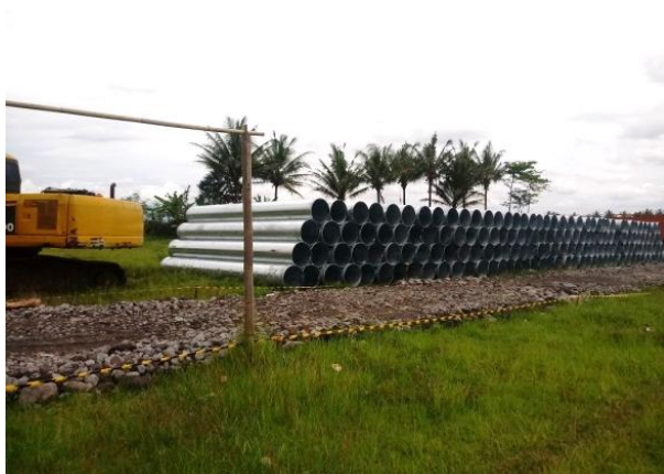
Gambar : Persiapan Pekerjaan Pemasangan Pipa Transmisi Air Baku
