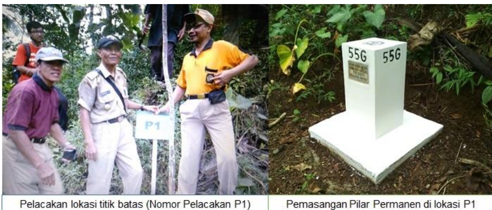
Gambar 8.2. Contoh Pelacakan dan Pemasangan Pilar Perapatan antara DIY dengan Provinsi Jawa Tengah di Desa Banjaroya
