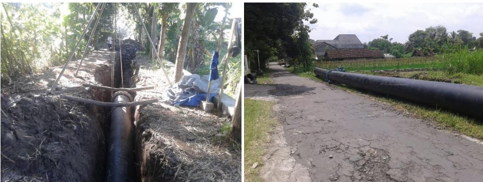
Gambar : Pekerjaan Jaringan Pipa JDU dari IPA Bantar ke Interkoneksi
