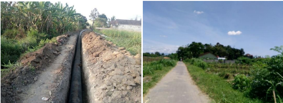
Gambar : Pipa Diameter 450 mm Jaten
